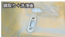
清浄。ゴム、樹脂、沈殿物を除去
